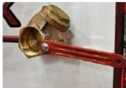
Запорные механизмы изготовлены из коррозионностойких материалов
