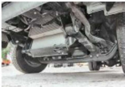
Радиаторы снизу не закрыты – существует вероятность их повреждения
